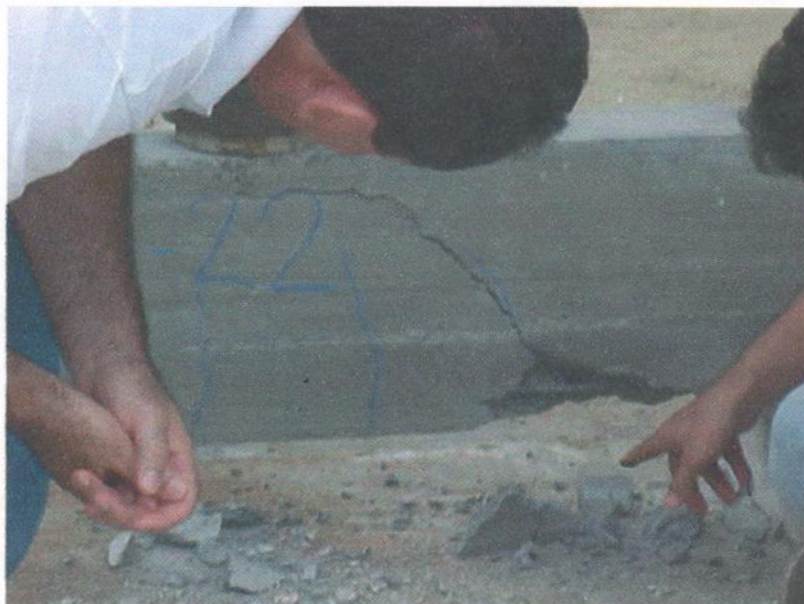
FOTO 09 – Ruptura da Viga (Amostra 04 – concreto Fck 22Mpa).
